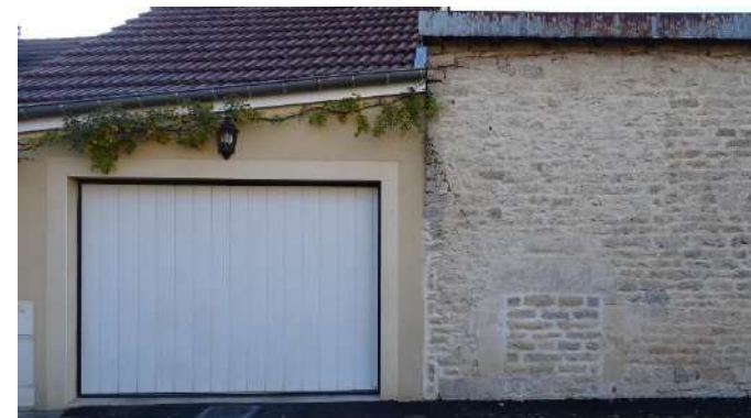
Mur recouvert d'un enduit gratté – 2, Impasse de la Fontaine
