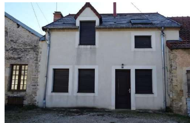
Mur recouvert d'un enduit gratté – 6bis, route de Richebourg
