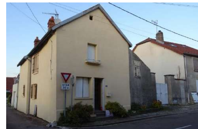
Mur recouvert d'un enduit peint – 10, rue St François
