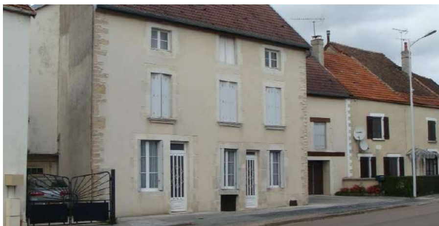
Mur en maçonnerie recouvert d'un enduit tyrolien – 25, route de Chaumont
