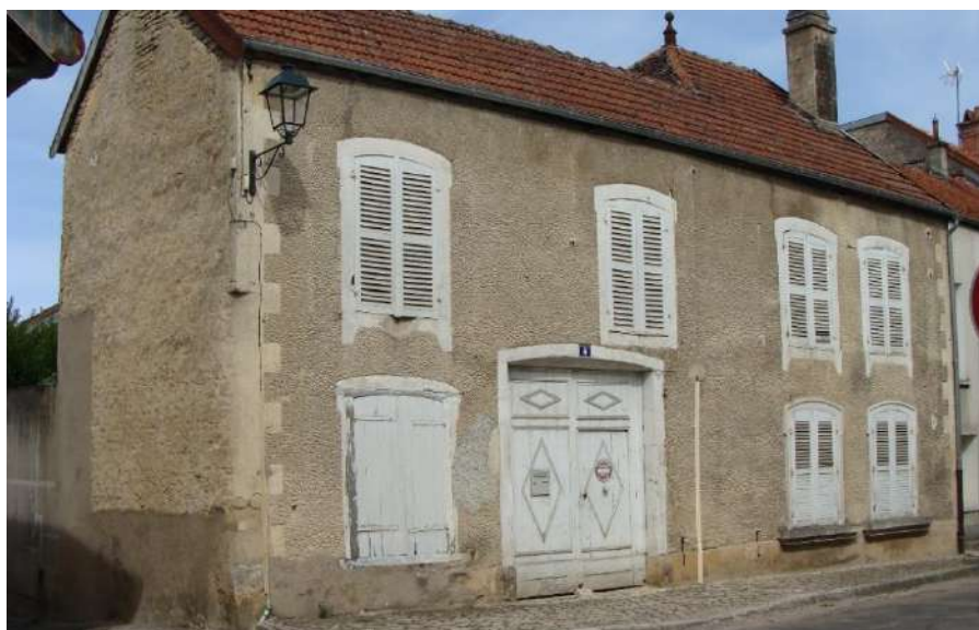
Encadrements de baie en pierre de taille et mur en maçonnerie enduite avec un enduit balayé – 4, rue Carnot
