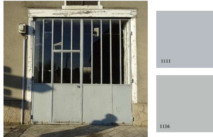
Porte métallique d'atelier gris bleuté - 24, route de Chaumont
