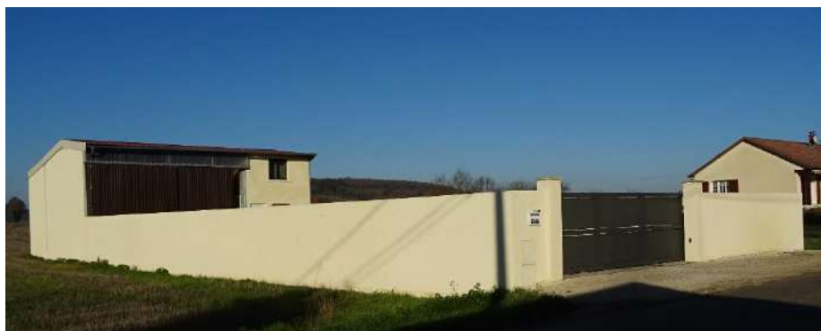
Mur recouvert d'un enduit – 15, route de Richebourg
