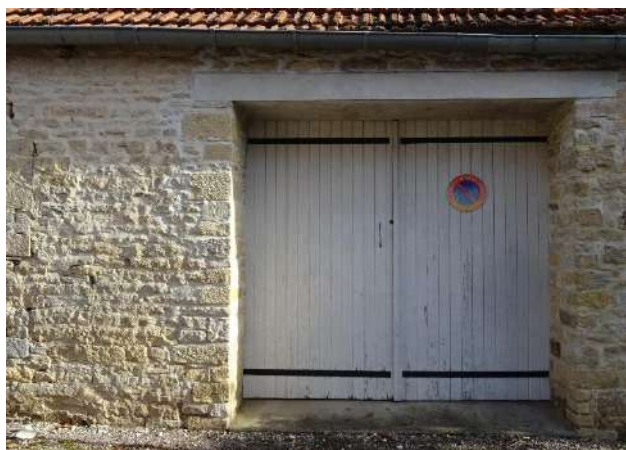
Porte de garage – 11, rue Carnot
