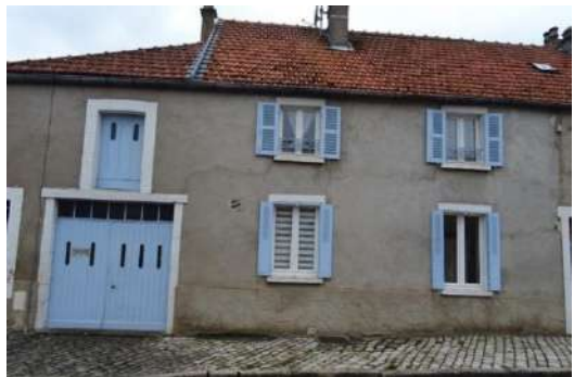
Menuiseries trop bleues – 15, rue de l'Amiral Décrès
