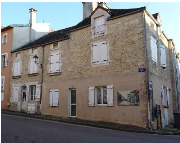
Mur en maçonnerie recouvert d'un enduit tyrolien – Ibis, rue Lasnet
