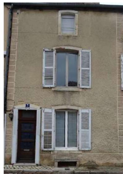
Mur en maçonnerie enduite avec un enduit balayé – 3, rue de l'Amiral Décrès et 11, rue de l'Aujon
