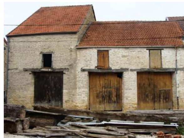
Les matériaux de construction : la pierre pour les murs, le sable pour les joints et les enduits, la terre cuite pour la toiture et le bois pour les linteaux de porte, la charpente et les menuiseries.
