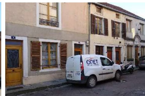
Fenêtres, volets et portes lasurés, faisant perdre son identité à la ville
