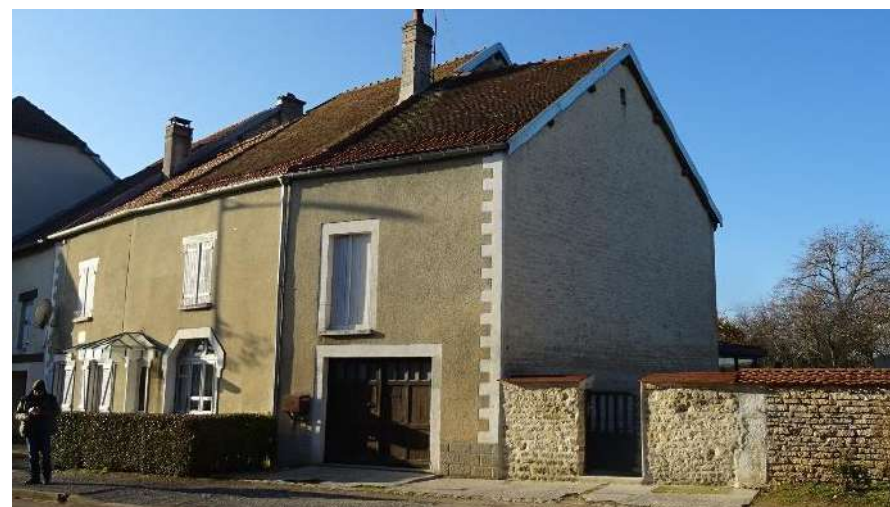
Mur en maçonnerie recouvert d'un enduit tyrolien – 27, route de Chaumont
