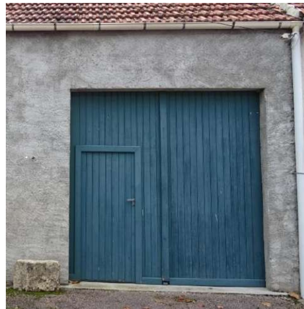
Porte de garage – 34, rue Carnot
