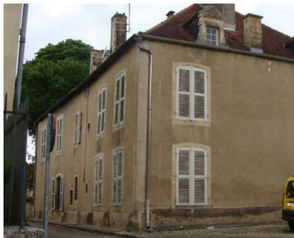
Encadrements de baie en pierre de taille et mur en maçonnerie enduite avec un enduit balayé – 7,9, rue de l'Amiral Décrès
