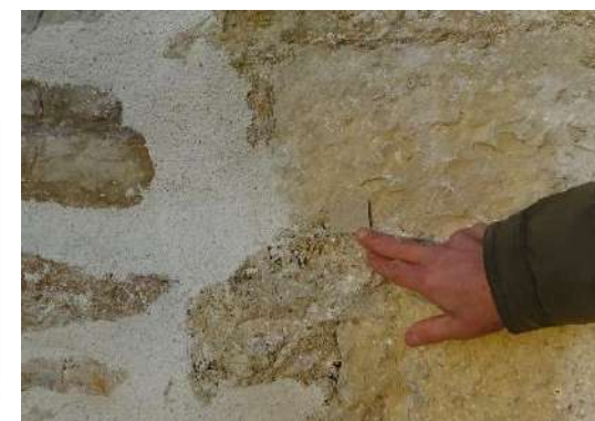
Mur en maçonnerie recouvert d'un enduit tyrolien – 27, route de Chaumont
