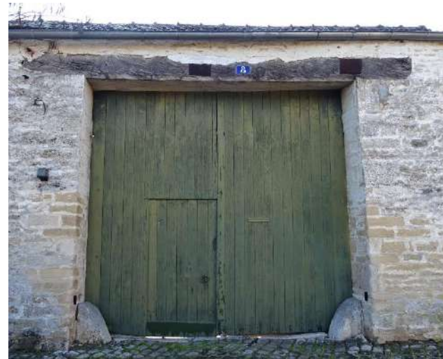
Porte charretière – 8, rue du Parc
