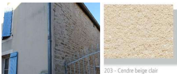
Mur en maçonnerie recouvert d'un enduit tyrolien – 1, route de Richebourg
