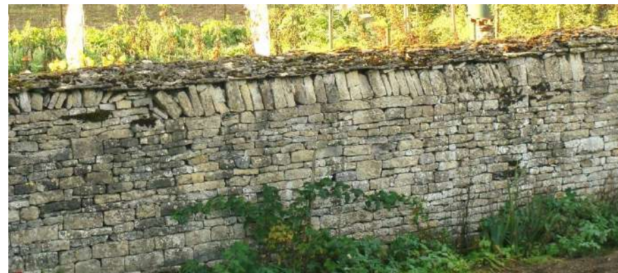
Mur constitué d'assises de pierres calcaires régulières, sans joint et recouvert de « pierre de lave ».
