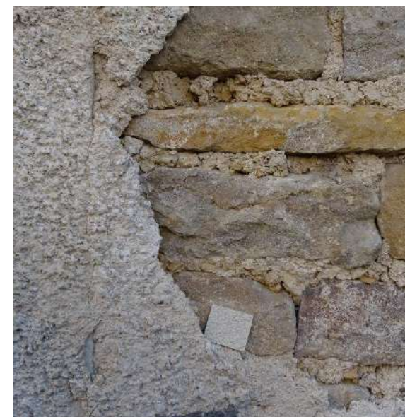
Mur enduit partiellement avec un enduit tyrolien – 15, rue Notre Dame
