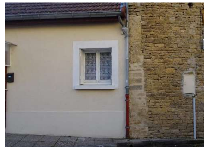
Mur recouvert d'un enduit peint – 1, rue de la Fontaine
