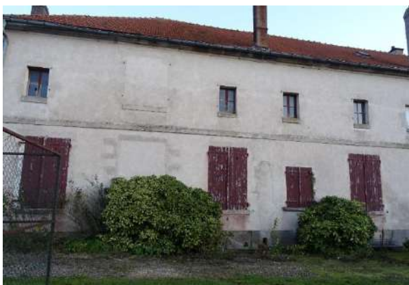
Mur en maçonnerie recouvert d'un enduit taloché – 2, rue des Religieuses
