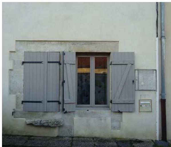
Mur recouvert d'un enduit taloché – 7, rue de l'Aujon
