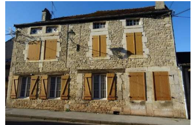
Volets pleins ton bois – 21, rue de Penthievre
